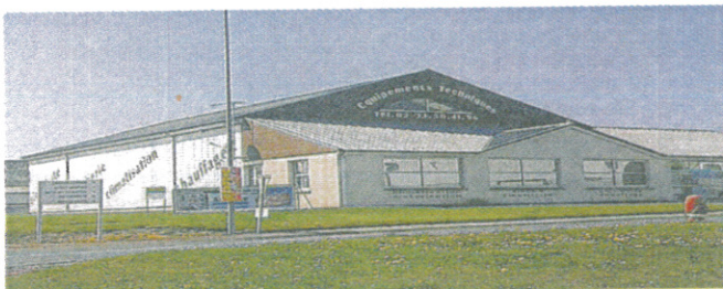
L'entreprise de M. Janier à Saint-Pair-sur-Mer.
